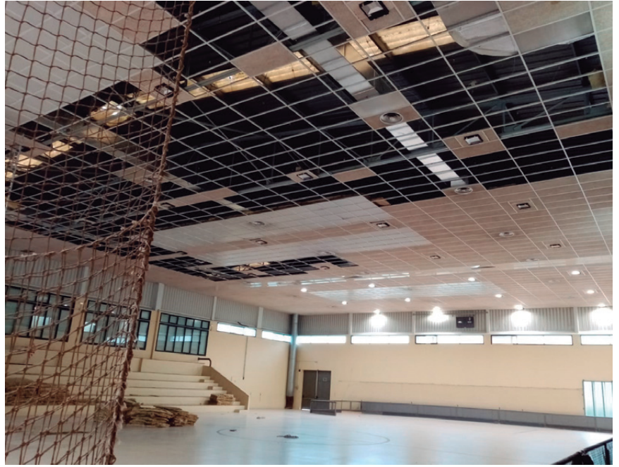
Desmuntatge del fals sostre, durant la primera fase
