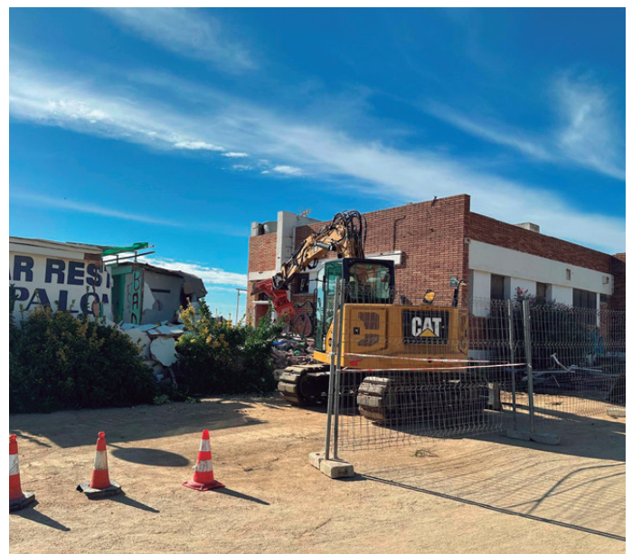
Imatge de l'inici de l'enderroc
