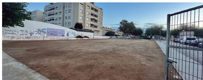
Pista futbol c. Santa Marta. Al tancament de l'edició, estava pendent del tancament perimetral i la instal·lació de porteries
