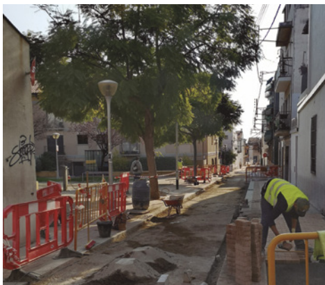
Obres al carrer Mont
