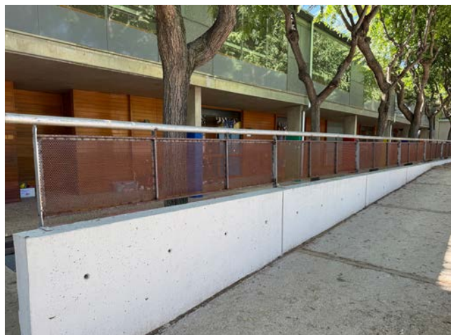
Substitució de la barana del pati del Vaixell Burriac
