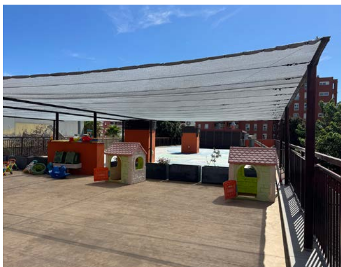
10 Nou tendal a la Bressoleta de l'av. Eduard Ferrés
