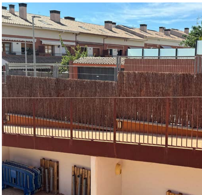
Instal·lació de bruc a les tanques exteriors de la Bressoleta
