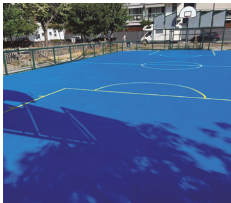
El nou paviment de la pista de Can Jorba
