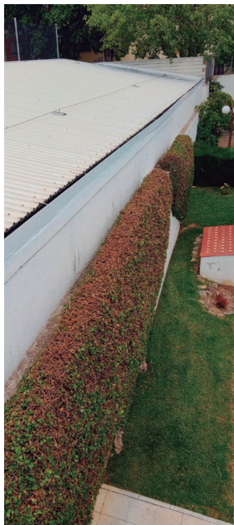
Arranjament coberta gimnàs Pérez Sala
