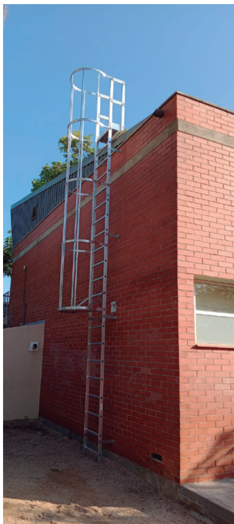
Instal·lació escala per manteniment a l'Escola del Mar
