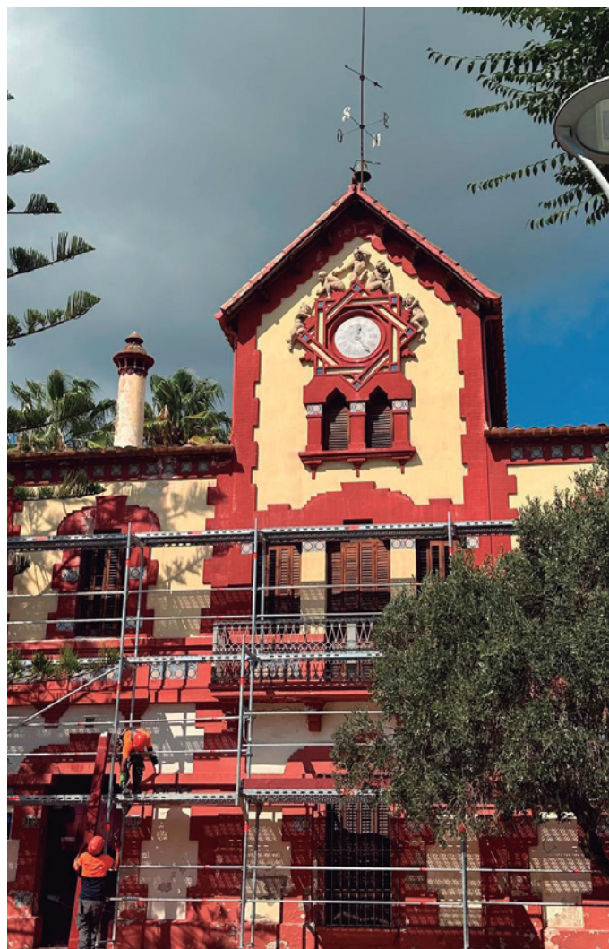
Façana de l'edifici amb la bastida d'obres
