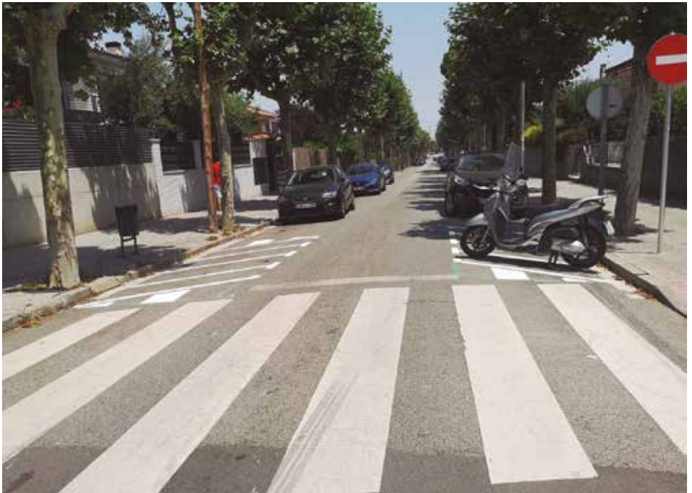
Obres de millora de la visibilitat al carrer Colom
