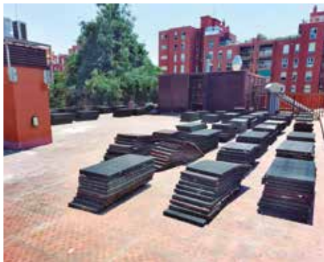
Obres a la coberta de La Bressoleta
