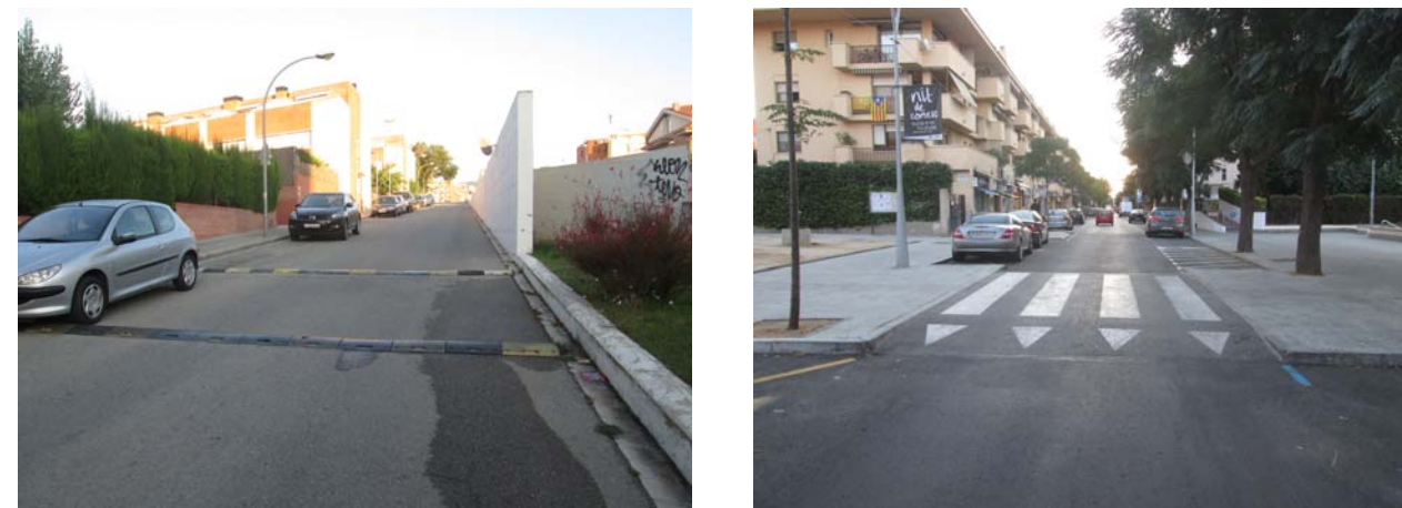
Foto 13 i 14 Banda sonora a la Riera d'en Cintet i Pas de vianants elevat al carrer Narcís Monturiol
