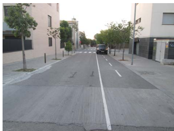
Indisciplina en el carril bici del Torrent de la Santa
