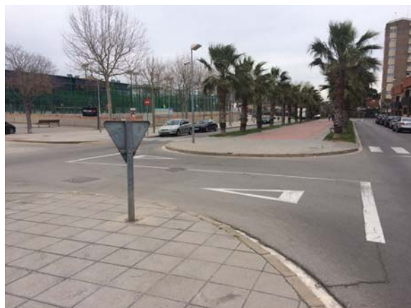
Avda. Eduard Ferrés manca gual de vianants a la rambla central
