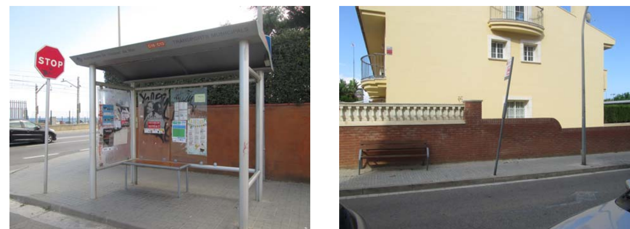
Foto 7 i 8 Marquesina a la parada Renfe Vilassar de Mar – Cabrera de Mar i Pal al carrer La Xinesca
